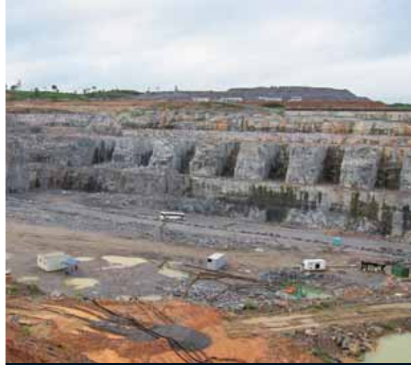
... wird er am Rio Xingu durch den Bau des weltweit drittgrößten Staudamms zerstört.
