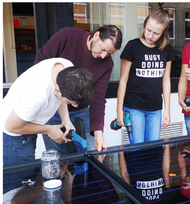
Der Bau einer Solaranlage mit Schüler:innen im Rahmen des Solartown-Projekts
