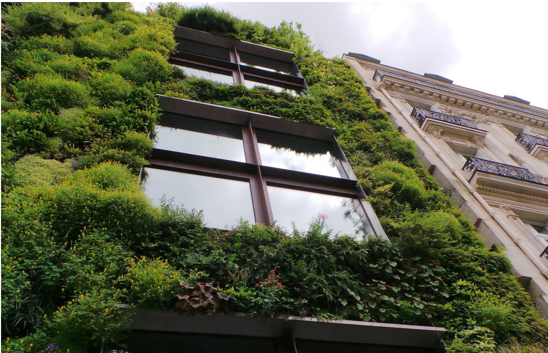
Abbildung 6: Die Begrünung von Fassaden kann sich positiv auf Wohlbefinden und Mikroklima auswirken.
